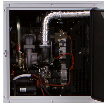
Abb. 5 Auspuffkrümmer und Motoraußenfläche
